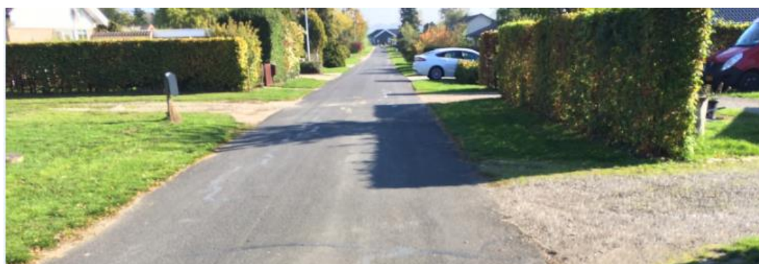
Foto 20: Rørsangervej set fra Bækkegårdsvej mod øst. Samme belægning som øvrige veje. Også her forekommer revner og revneforseglinger.
