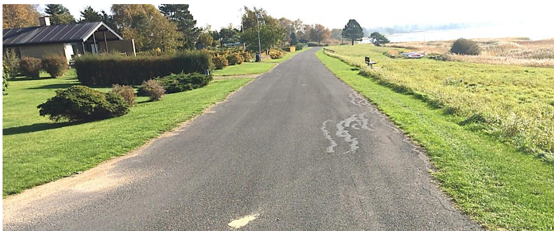
Foto 9: Søbredden fra Bækkegårdsvej i vest mod Hejrevej i øst. Der forekommer som på de øvrige veje sporadiske krakeleringer.
