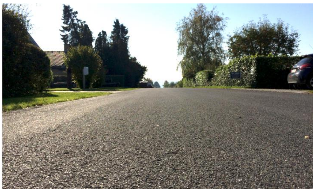
Foto 15: Hejrevej set fra nord mod syd: Belægningsoverfladen er efterhånden lidt slidt og revnet, men har alt i alt klaret sig godt, alderen taget i betragtning.
