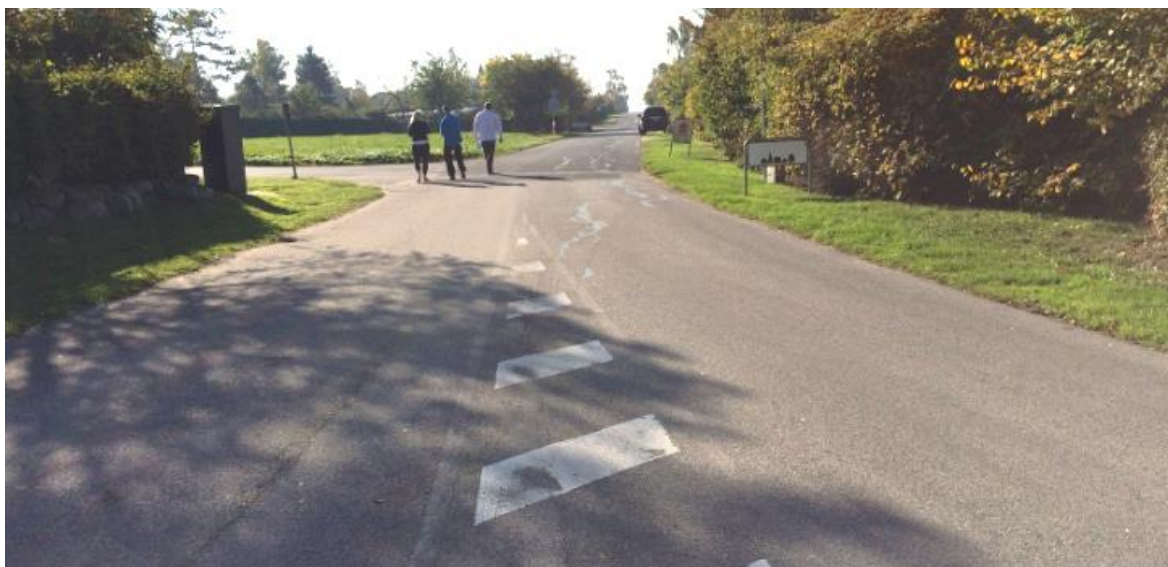
Foto 2: Bækkegårdsvej set fra Fredriksværkvej mod syd. Bemærk det gamle landevejsslidlag (lysere stenfarve end øvrig belægning på Bækkegårdsvej) som fortsætter ned til krydset ved Hejrevej.
