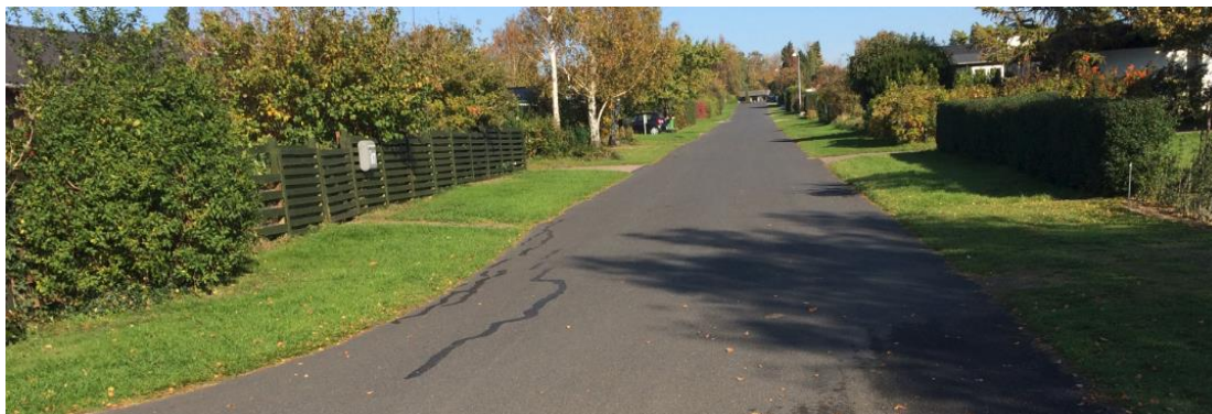
Foto 11: Hejrevej set fra Søbredden mod nord. Der ses en tværgående lunke ved tilslutning til Søbredden.
