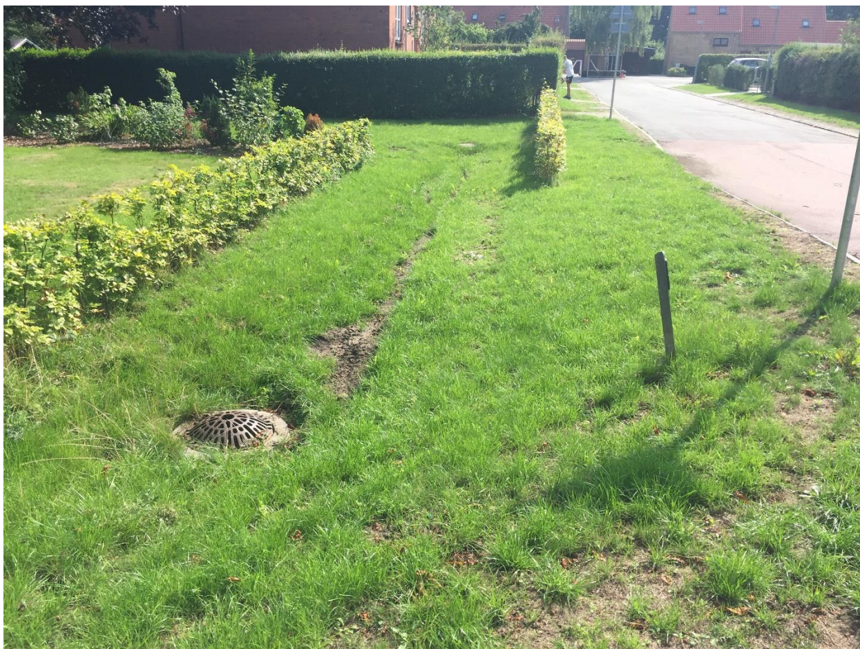
Foto 4: Eksempel på vejbrønd, der er forsynet med kuglerist. Der skal evt. etableres kantsten rundt i svinget for at beskytte kuglerist mod tung trafiklast.
