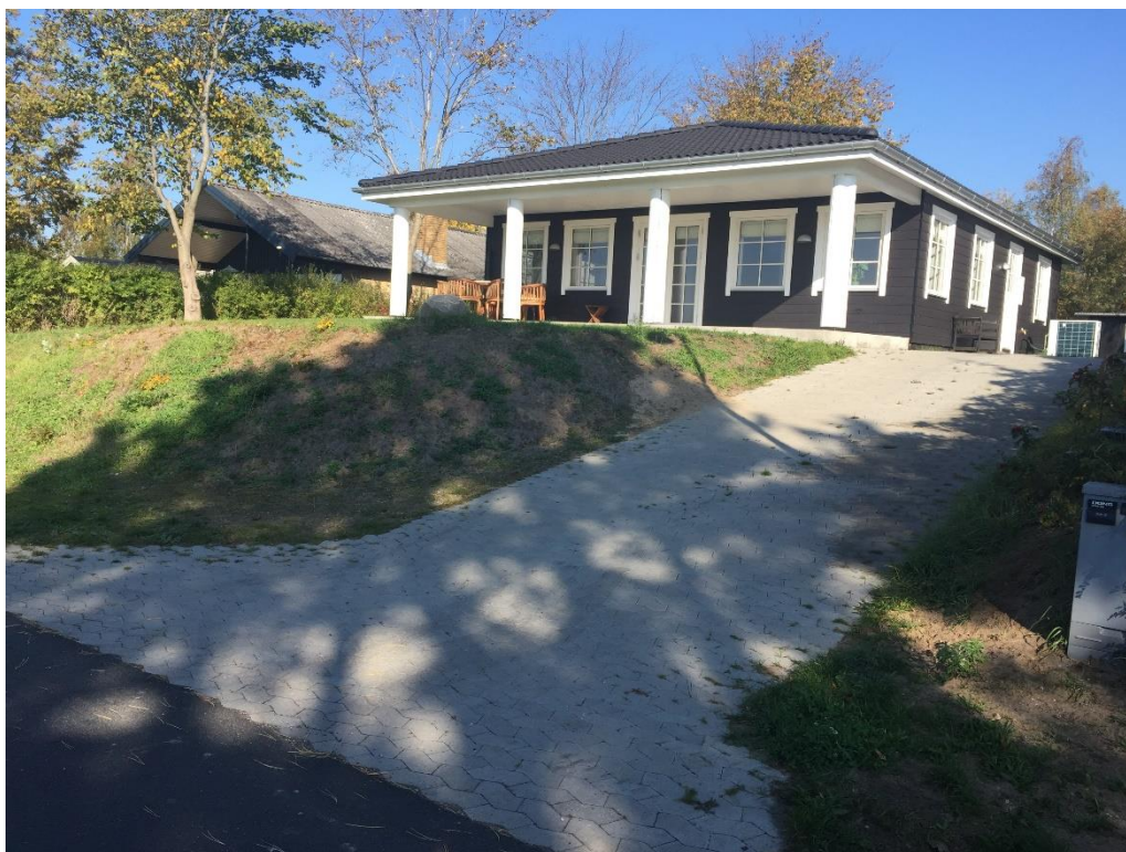
Foto 1: Mange indkørsler afvander til fællesvej
