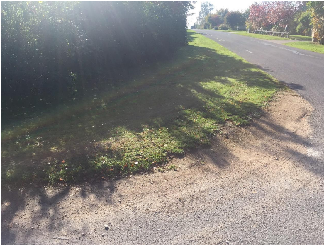
Foto 3: Hjørnet af Svanevej og Bækkegårdsvej, hvor der under regn ofte samler sig vand.
